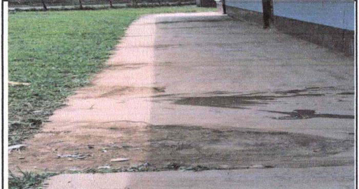
Foto 2: SUSTITUCIÓN DE PISO DE CONCRETO DE COREDOR DE LA ESCUELA
