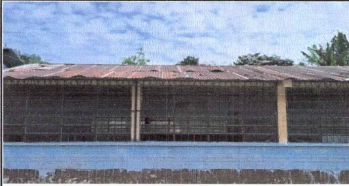
Foto 1: SUSTITUCIÓN DE LAMINA , POR LA MINA TROQUELADA CALIBRE 26 ALUZINC
